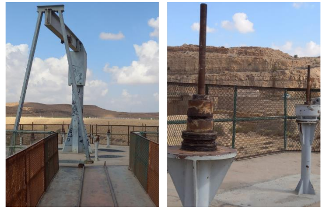
شكل 9 أ، ب. تلف وعطل الروافع اليدوية والرافعة الدوارة المستعملة في فتح وقلق البوابات ببرج المأخذ وماسورة الصرف. المصدر: الباحثان، 2023
