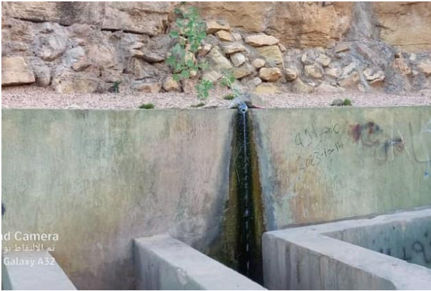
شكل 7 ب. تصدع في الكثف الايمن للسد وتسرب المياه من البحيرة.
