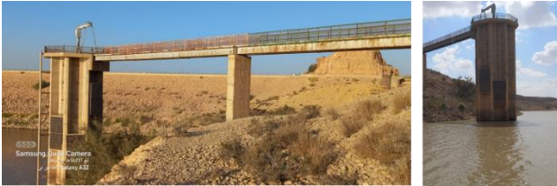
شكل 5 أ، ب. برج المآخذ وماسورة الصرف.
