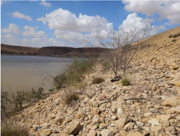
شكل 7 أ. انهيار في طبقة حماية الميول الصخرية من جهة بحيرة السد.
