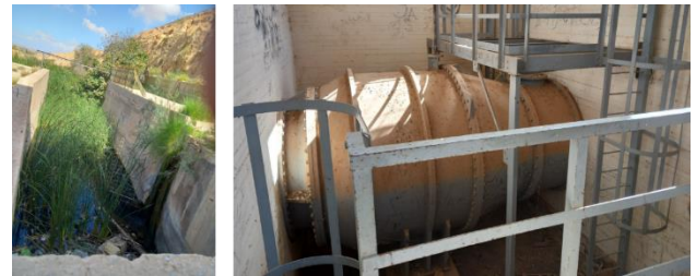
شكل 10 ب. نمو النباتات والأشجار ووجود كميات من الاتربة والمخلفات بحوض التهئة بداخله المصدر: الباحثان، 2023
