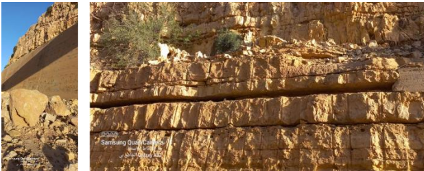
شكل 8 أ، ب. انهيار في الجبل الذي يخترقه مجرى المفيض وسقوط الاحجار بحيرة السد.
