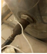
شكل (3) فتحة خروج الماء من السخانة خلال الأنبوب.
