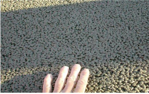
شكل (4) يوضح التشطيب النهائي للخرسانة النفاذة
