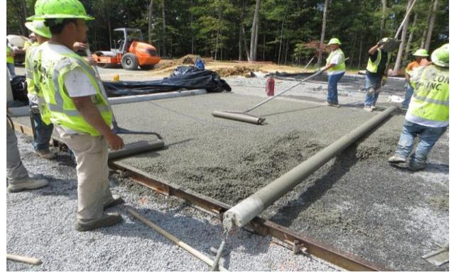
شكل (3) يوضح رصف ودمك الخرسانة النفاذة في الموقع ولتحسين أداء خواص الخرسانة من حيث قوة تحمل الضغط والنفاذية يمكن استخدام المضافات لتحسين الخواص الأداينية والهيدروليكية للخرسانة.
