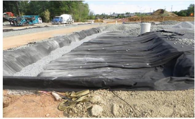
شكل (2) يوضح حاجز المياه الجوفية الموجود أسفل طبقات الرصف
