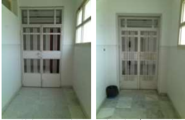
شكل 9. يوضح الأبواب المعدنية التي تعيق حركة الممرات باتجاه سلالم الطوارئ المصدر : (البحاث، 2019)
